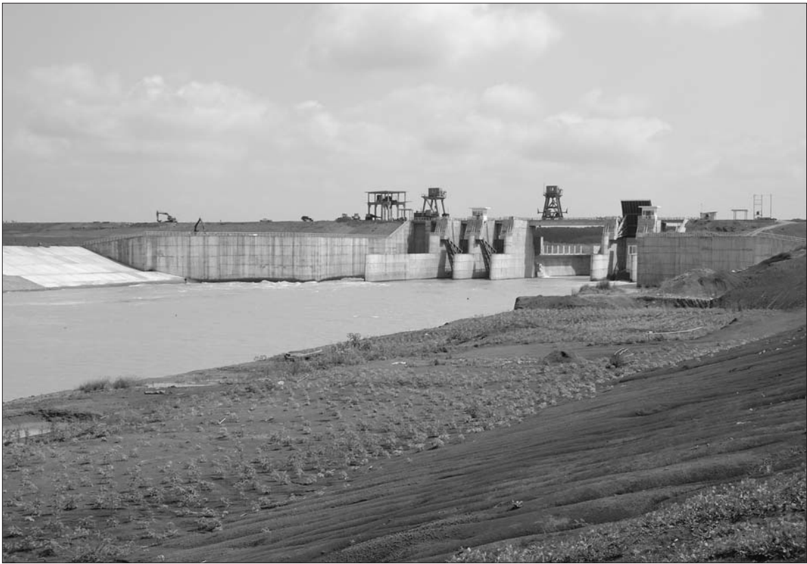
Dự án thủy lợi Phước Hòa cơ bản chấp hành các quy định về quản lý chất lượng công trình Ảnh: TS
